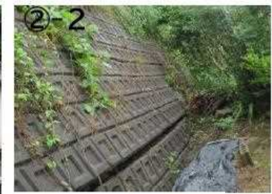
斜面崩壊、ブロックの亀裂
