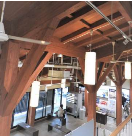
図-1 非住宅(砂丘ビジターセンター)
