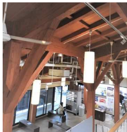
図-1 非住宅(砂丘ビジターセンター)
