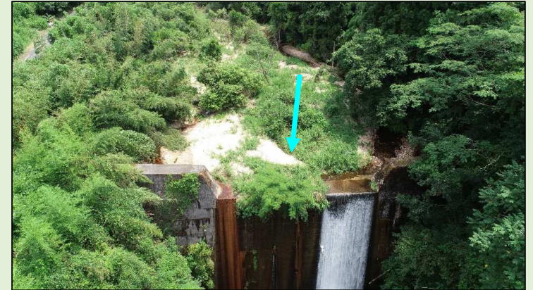
今回の大雨で満砂となった砂防堰堤の例
