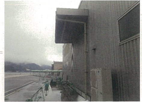
ターミナルの北側壁面にある 底の撤去、窓は壁に 室外機は移設
