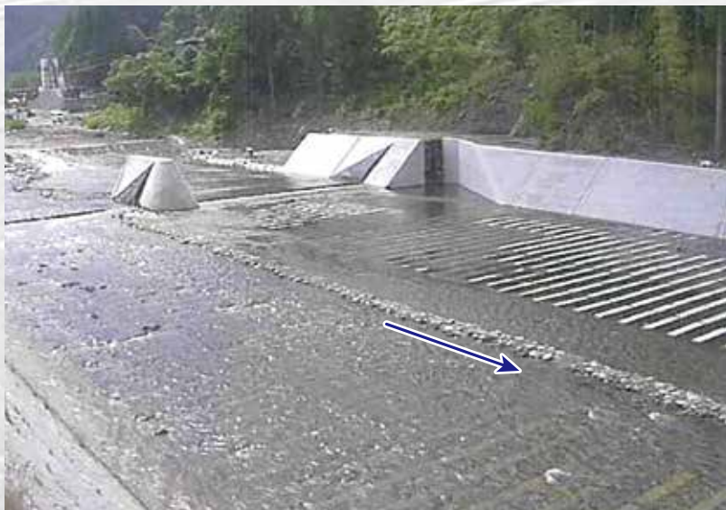
日野川河川改修工事のうち井津羽堰改修状況
