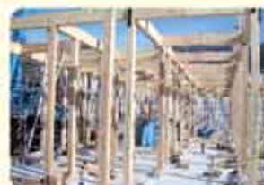
← 県産材を使用した「LVL(単板積層材)」の利用例
