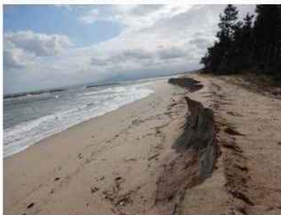
写真-3 台風襲来直後の富益工区5号人工リーフ背後の侵食状況
