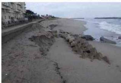
写真-2 台風襲来後の皆生工区の浜崖、消波ブロック露出の状況
