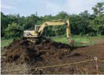
② 遺構がある地層までを機械を使って少しずつ掘ります。
