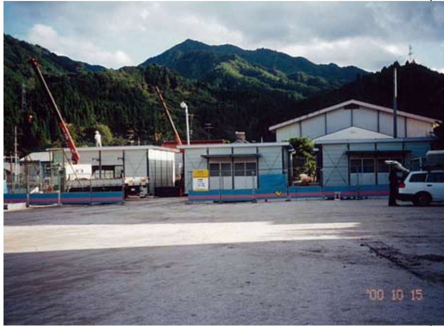
建設中の仮設住宅
