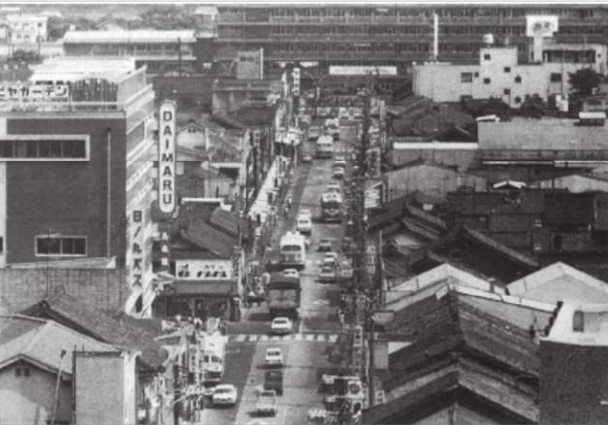
写真 米子駅前通り（整備前）
