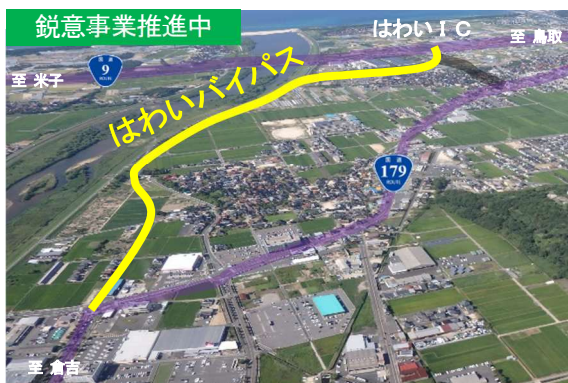
はわいバイパス（はわいIC付近）
