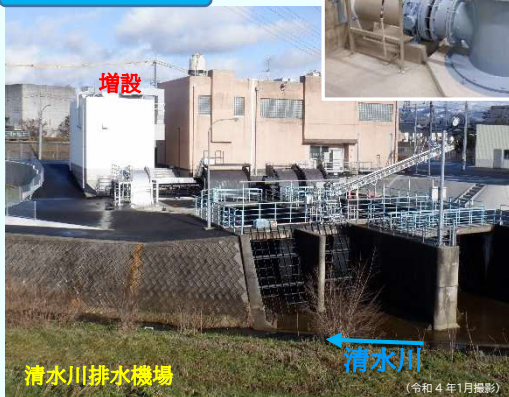
排水機場整備により都市部の浸水被害を軽減
