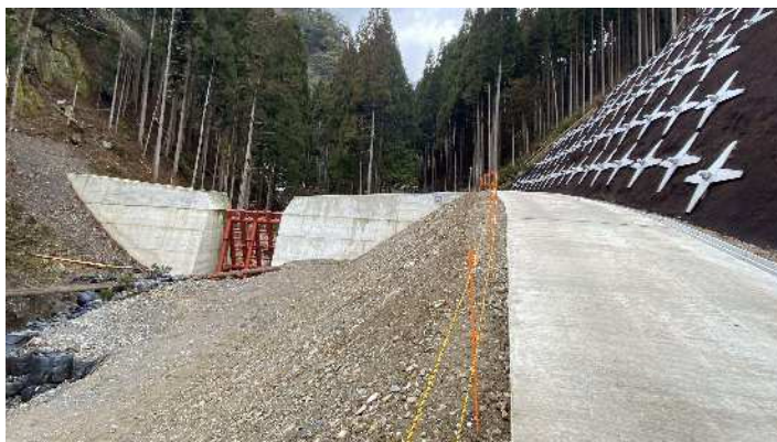
豪雨により土石流の発生した溪流に砂防えん堤や溪流保全工を緊急に整備し、地域を土砂災害から守ります。
