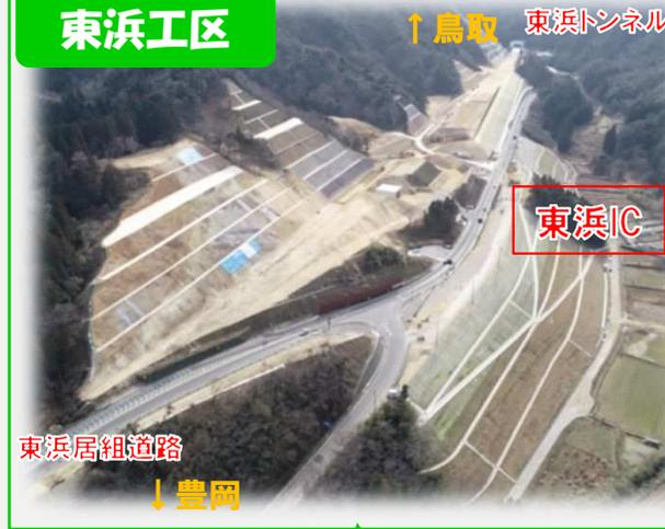
東浜工区では、残っていた大規模な山切工事が完了し、岩美道路全体の形が現れてきました！引き続き、山切でできた長大斜面を保護するための法面工事が本格的に始まります。
