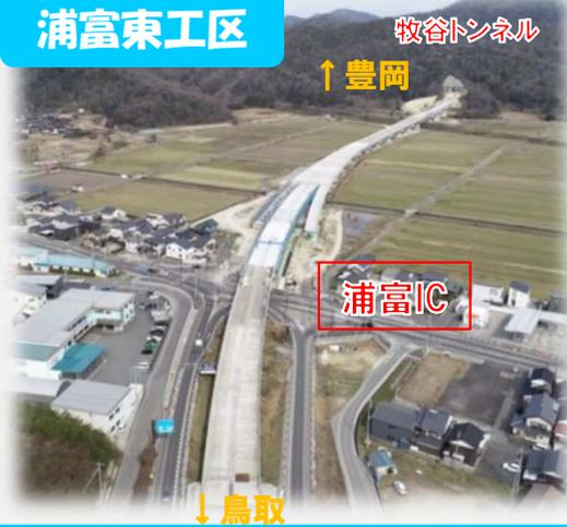
浦富IC周辺では、浦富高架橋の床版コンクリートの施工が進み、橋が繋がるとともにインターチェンジの完成形が見えてきました。
