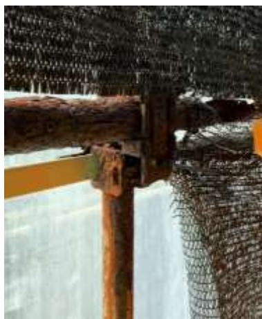
内部部材劣化破損状況
