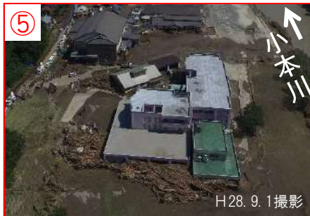
流木堆積状況
