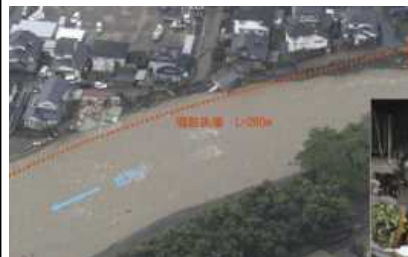
河岸侵食による家屋倒壊及び流出
