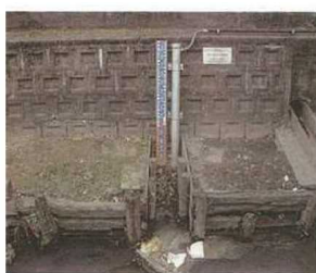
水位計設置状況
