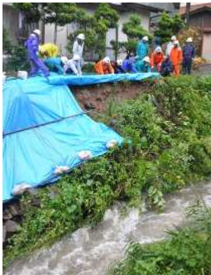
〈三朝町水防活動状況〉
