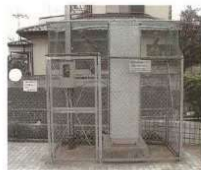
観測装置設置状況
