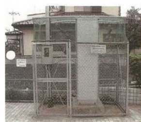
観測装置設置状況
