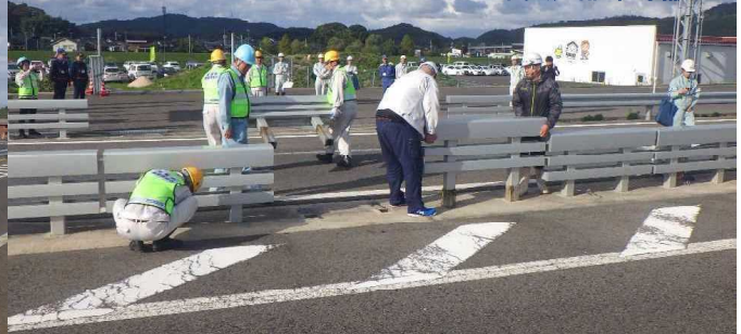
中央分離帯等撤去
