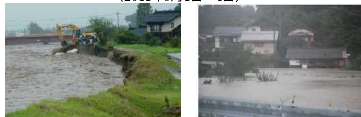
米子市河岡(佐陀川)の被災状況 米子市青木(小松谷川)の冠水状況
