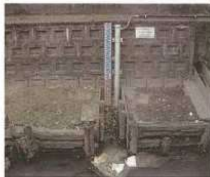
水位計設置状況
