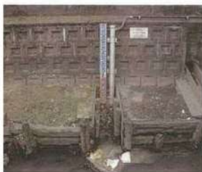
水位計設置状況
