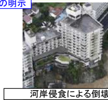
河岸侵食による倒壊
