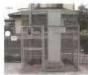
観測装置設置状況
