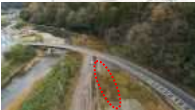
<日南町管内対応用土のう仮置場>
