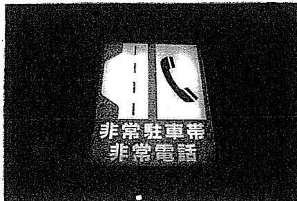
非常電話・非常駐車帯 誘導表示板 (電光式)
