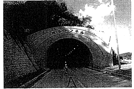
起点側坑口 (三朝側)
