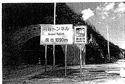
起点側坑口 (三朝側) トンネル延長表示板・市町村境界表示板
