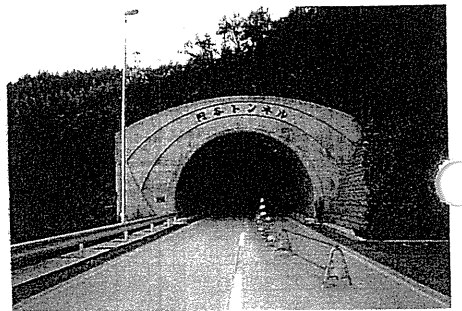
終点側坑口 (倉吉側)
