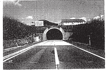
起点側坑口 (岡山側)
