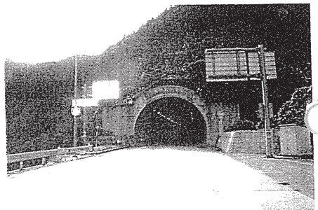
終点側坑口 (鳥取側)
