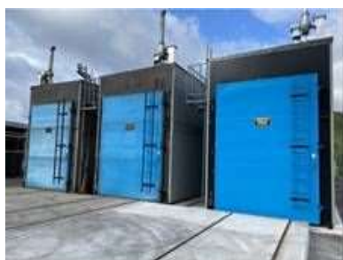
木材乾燥機（R3.10完成、若桜町）
