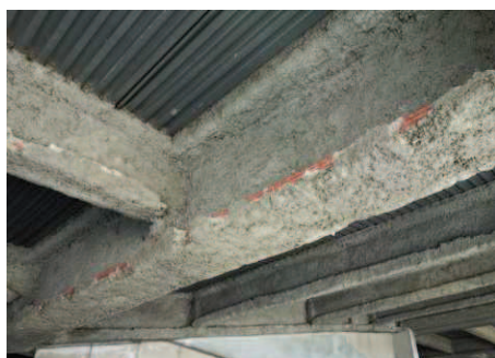
参考：吹付けアスベスト
