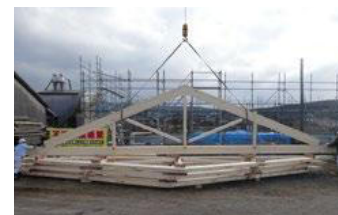
山形トラスの組立作業
