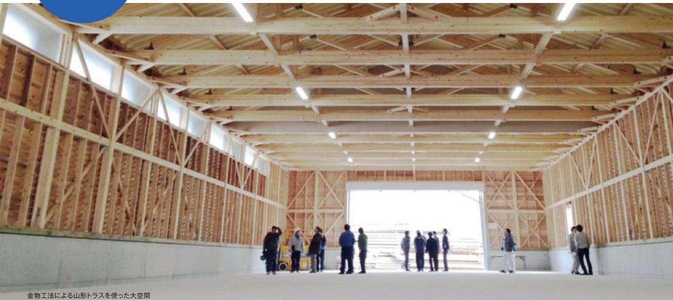
金物工法による山形トラスを使った大空間
