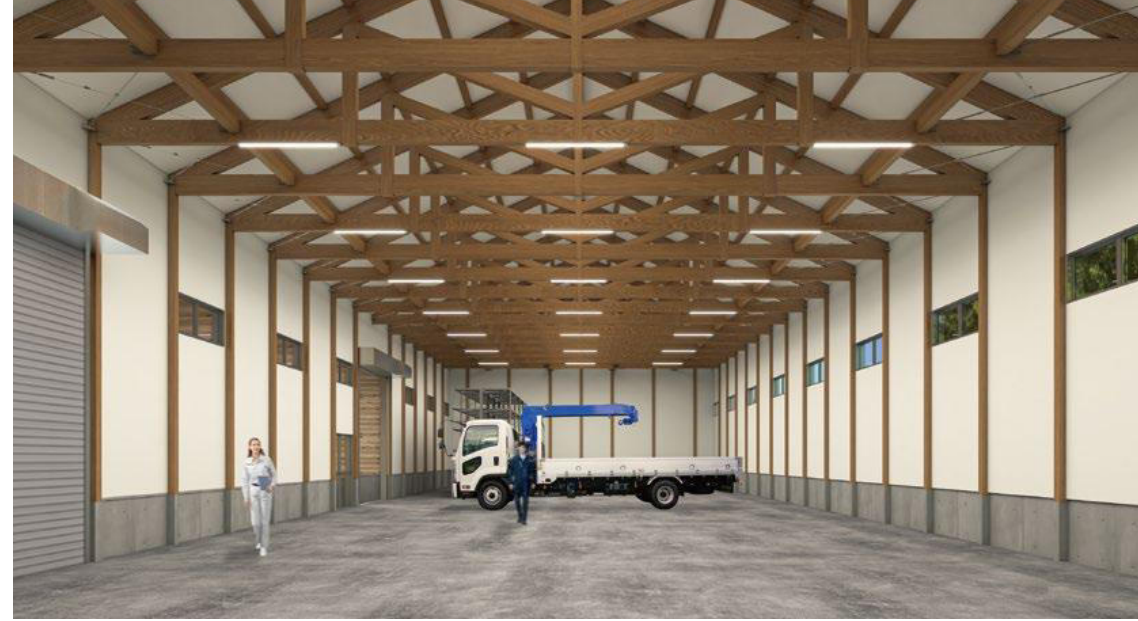
倉庫内観 一般流通材で大空間を構成
