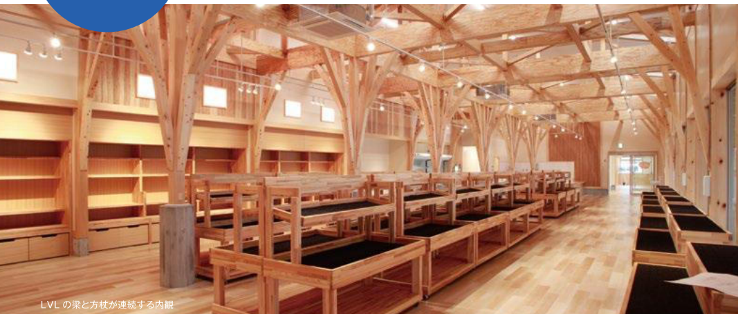
LVLの梁と方杖が連続する内観
