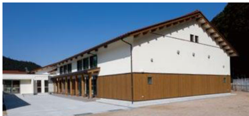
外観（遊戯室側）
