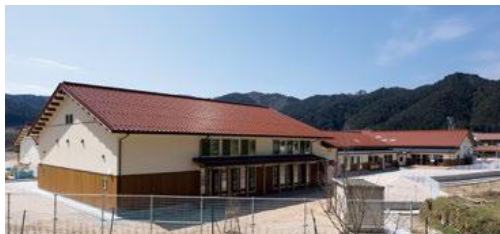
外観（遊戯室側）
