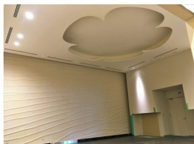
重要文化財展示室の状況
