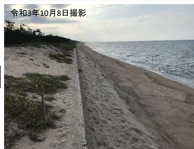
④ 北条海岸(天神川河口より左岸側の状況)
