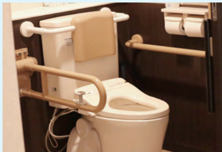
多目的トイレ
