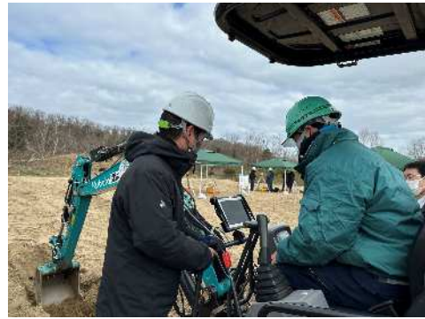
ICT建機を用いた施工演習(施工業者向け) 【省力化】操作の半自動化により丁張作業が不要
