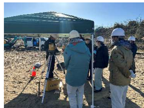
ワンマン測量の実技演習(発注者向け) 【省力化】起工測量等の作業に必要な人員を削減
