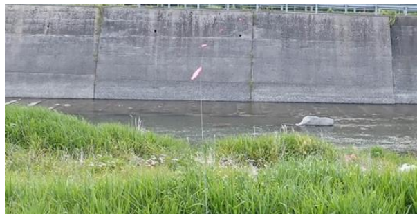
写真2 テグス設置状況（ピンク色のテープは目印）
