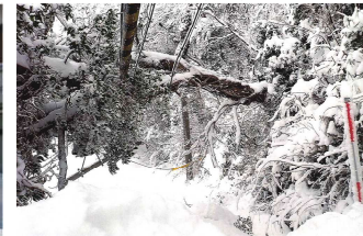
道路区域外からの倒木により全面通行止め
