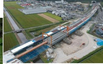
▲山陰近畿自動車道「岩美道路」浦富高架橋の桁架設状況
