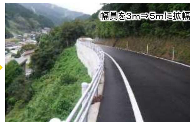
・地形的に全面的な改良が困難な中山間地では、幅員狭小の現道を部分的に拡幅、R5.1の豪雪では国道482号が通行止めとなった際のう回路として活用され、集落の孤立を回避
