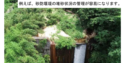
岩倉川砂防堰堤の堆砂状況（R3.7月豪雨後）（倉吉市）
