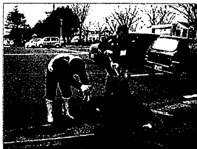
側溝の沈殿物除去
