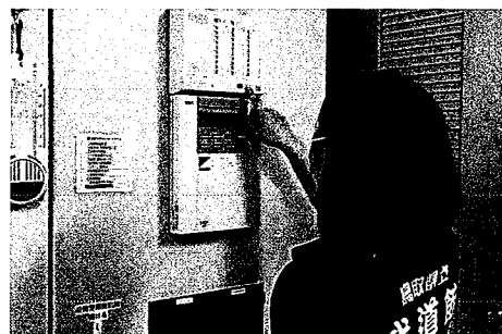
警備機器を利用した異常箇所の確認
