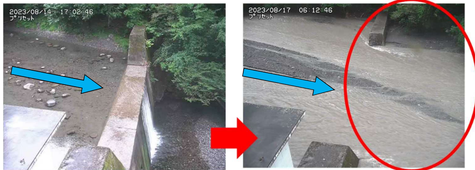
台風7号の出水で土砂が堆積(佐治川ダム上流砂防ダム監視カメラ)
