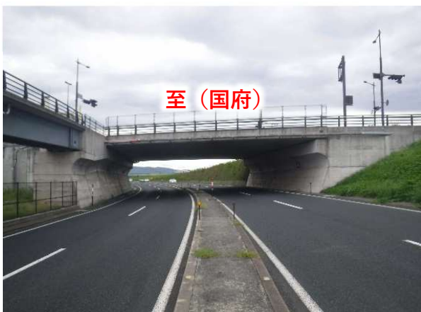
平常時写真 (起点側)
