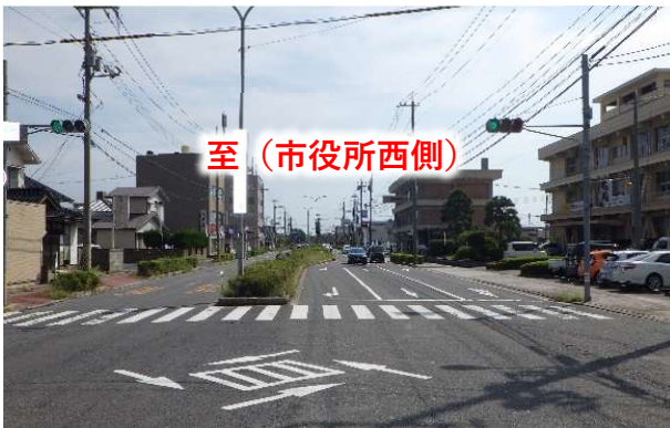
平常時写真 (起点側)
