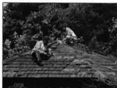
日本庭園東屋屋根の修繕
