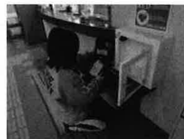
AED(自動体外除細動器)の日常点検
