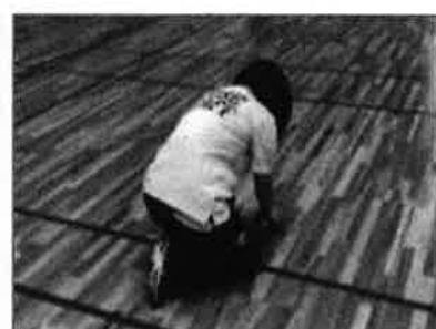
アリーナ床の点検
