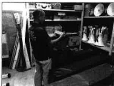
陸上機器の点検
