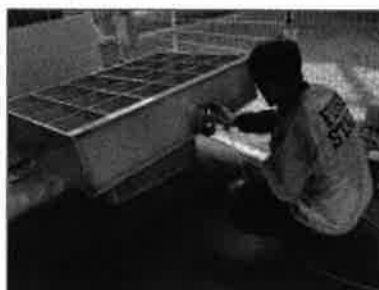
体育館下足箱の塗装
