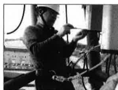
テニスコート夜間照明安定期の修繕
