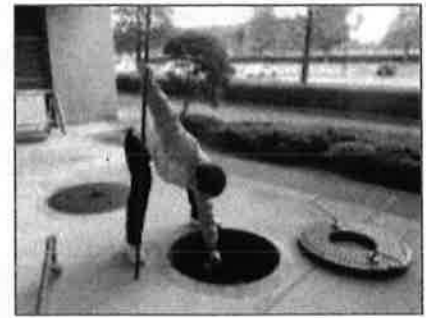
県民体育館 地下タンクの漏洩点検
