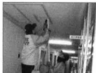
陸上競技場ロビー排煙口の修繕
