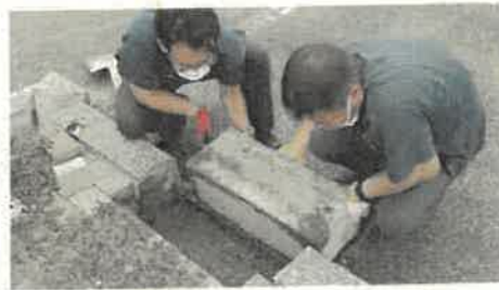
職員による道の駅駐車場縁石補修
