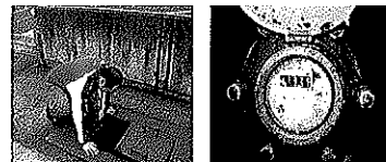
【水道メーターの確認作業】
