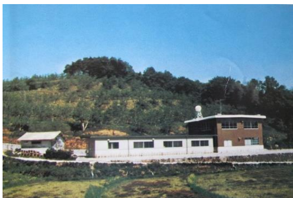
河原試験地の庁舎改築（昭和 53 年）
