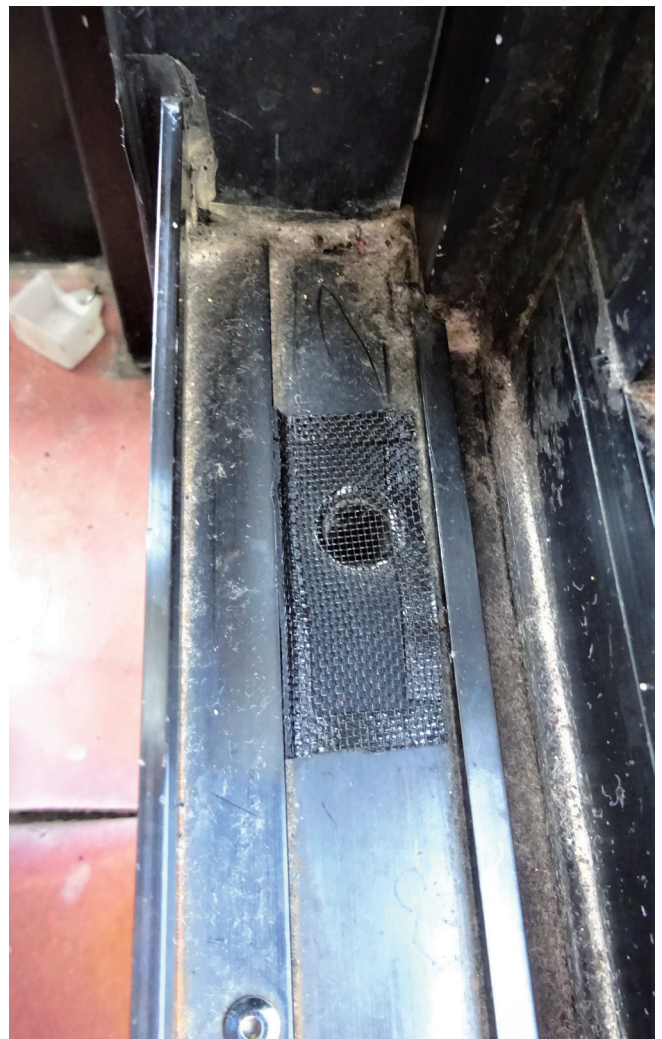
図5. サッシ(はめ殺し窓枠)の水抜き穴を網戸ネットで塞いだ様子。
